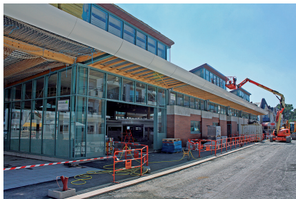
Fin de la construction des nouvelles halles du marché en 2013.
